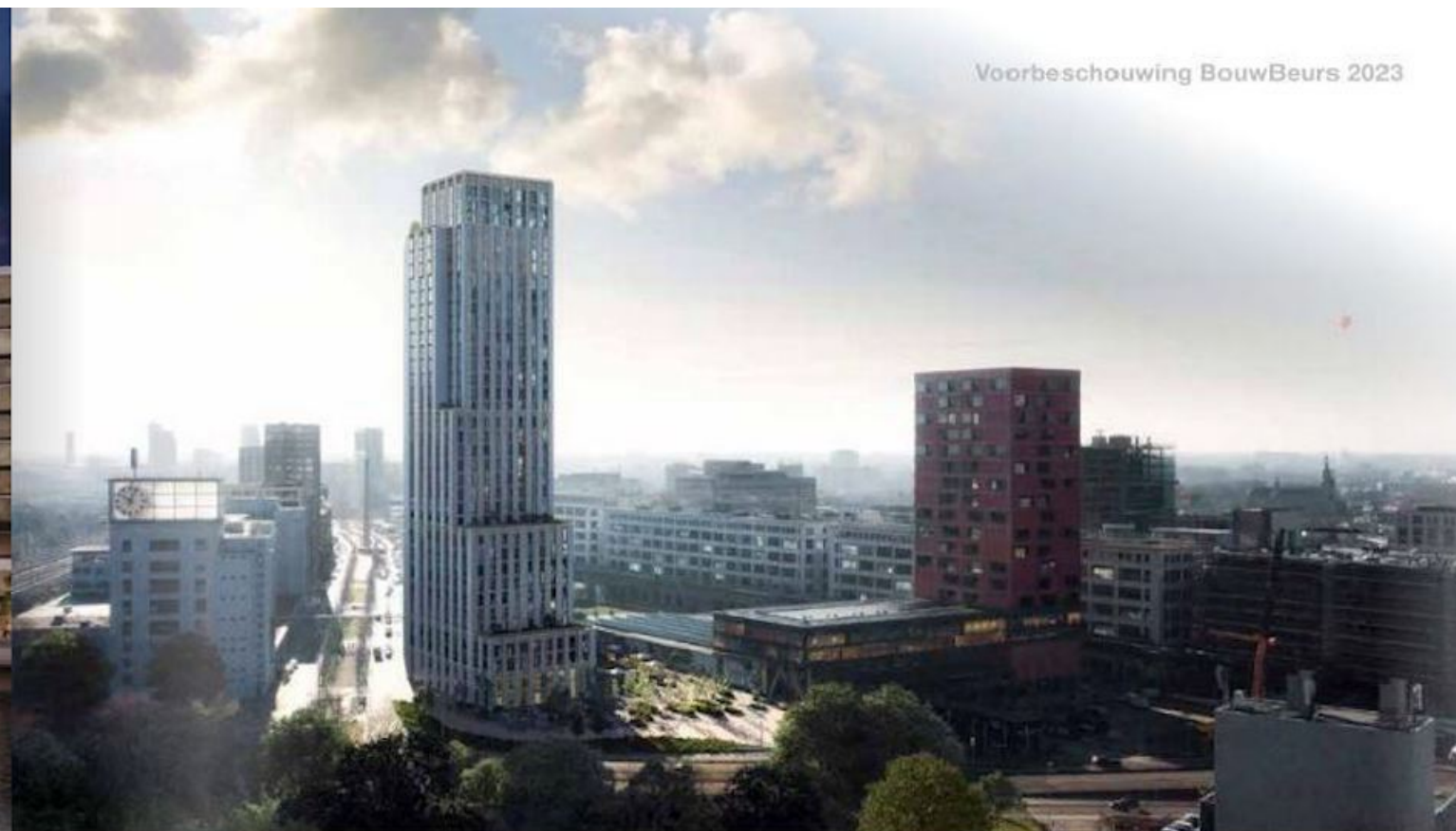
De gevel van de 109 meter hoge woontoren Niko op Strijp-S in Eindhoven wordt vanwege het ontwerp bewust nog op traditionele wijze gemetseld. (Beeld: De Zwarte Hond)
